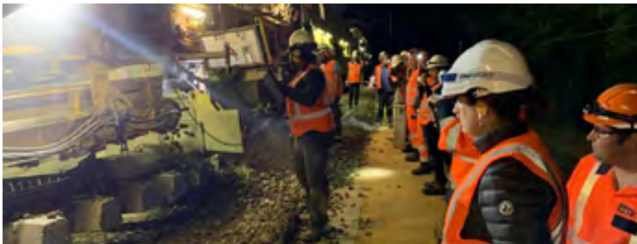
Visite du chantier de régénération de la ligne de chemin de fer entre Montargis et la Charité-sur-Loire.
